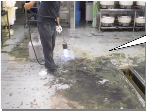
熱と酢によるエポキシ塗床材の剥がれ・酷い汚れ！
